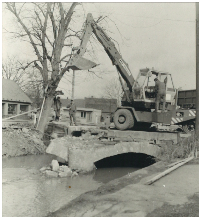
DŘÍVE: Bourání původního kamenného silničního mostu na návsi v roce 1980. Za ním je vidět roh betonového rámu stávajícího mostu.
