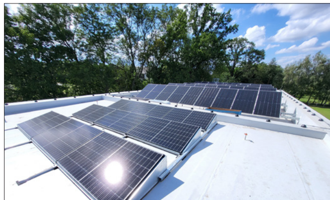
Střecha hlavní budovy je pokryta fotovoltaickými panely.
