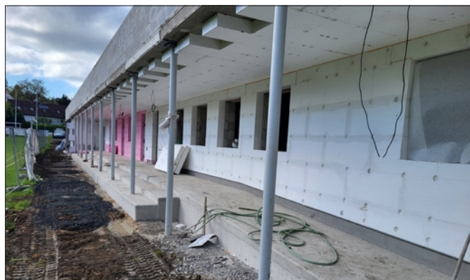
Obvodové stěny, střechy i podlahy budovy jsou masivně zateplený.
