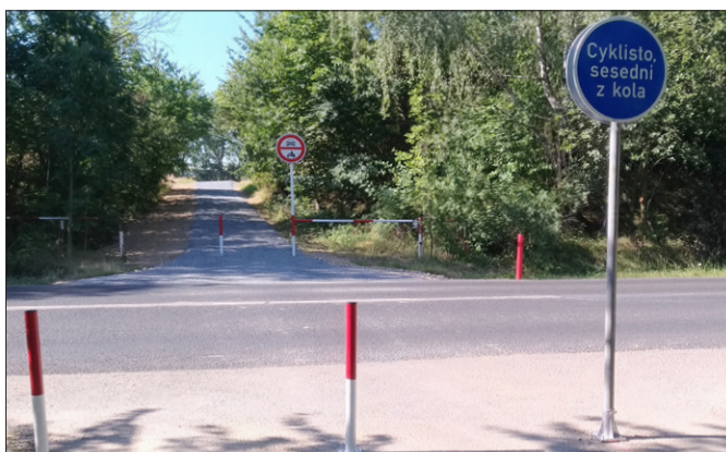
Zábrany, závory a značky byly instalovány také na nově vybudované cestě do Modletic. Hlavně na místě přecházení frekventované silnice.
