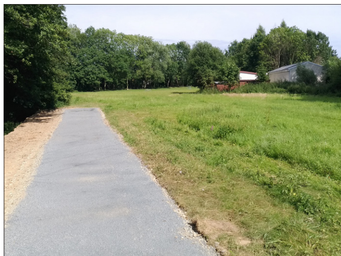
Nově vybudovaná cesta nás dostane až těsně k Modleticím.
