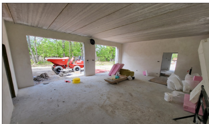
Na místě bývalé hospody vzniká prostorná dvougaráž pro techniku správy sportovního areálu a obce i přilehlá dílna.
