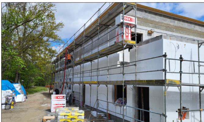
Práce na Sportovním a společenském centru pokračují. Pracovníci stavební firmy pracují na zateplení objektu.
