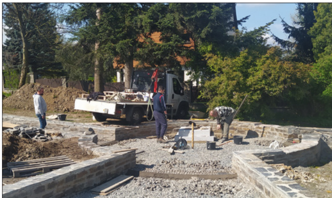
Koncem dubna pracovníci kamenictví rozebrali pomník na původním místě, jednotlivé části očistili a začali je usazovat na nové místo.
